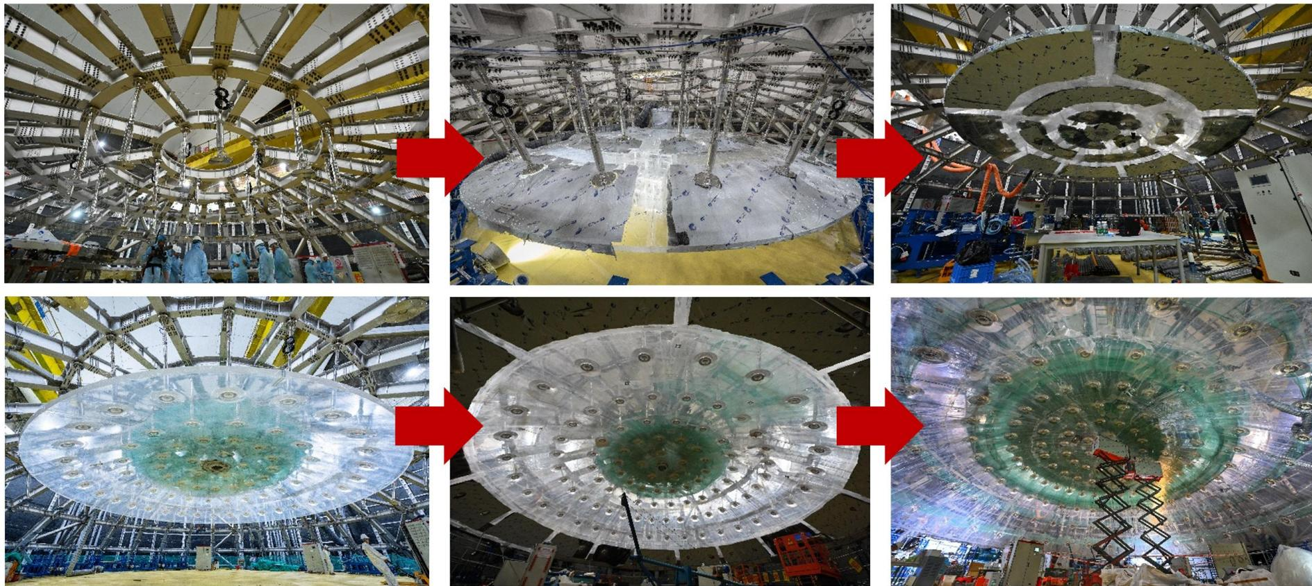
265块12厘米厚有机玻璃弯板利用**本体聚合**方法在实验现场粘接
